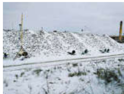
Подсоединение вентиляторов к кагату.
