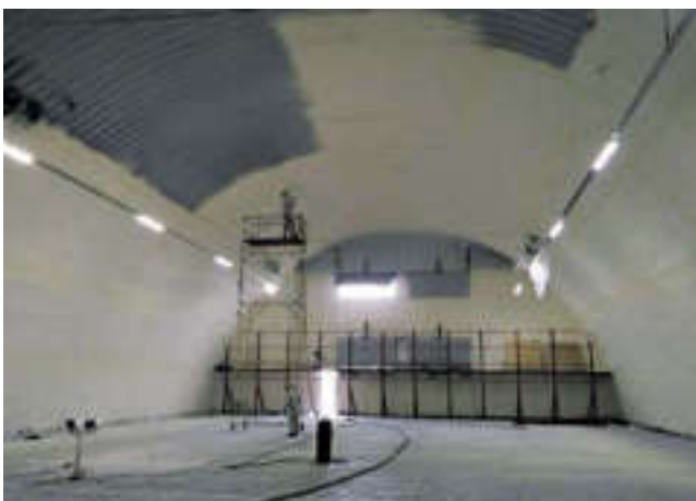
Напыление ППУ в овощехранилище навалного типа в период монтажа вентиляции и подпорных стен.
