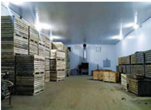
Небольшое хранилище моркови и модуль с одним вентилятором.
