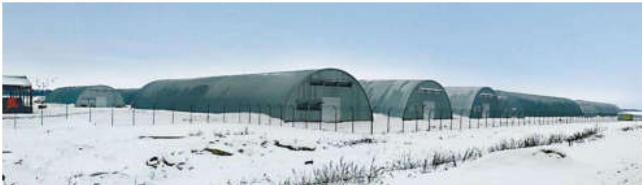
Комплекс картофелехранилищ, Новомосковский район, Тульская область. Все хранилища с утеплены ППУ и оборудованы вентиляционно-климатическими системами «VENTOGLAS™».
