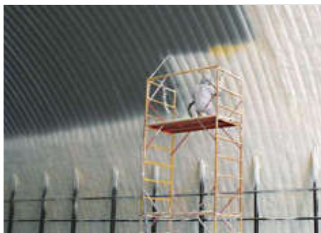
Напыление ППУ внутри ангара сразу после возведения сооружения.
