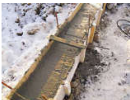
Зимой, при заливке фундамента используется электрический обогрев бетона.
