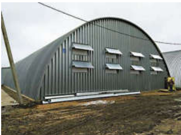
Двухкамерное картофелехранилище контейнерного типа. Тульская область, Богородицкий район.
