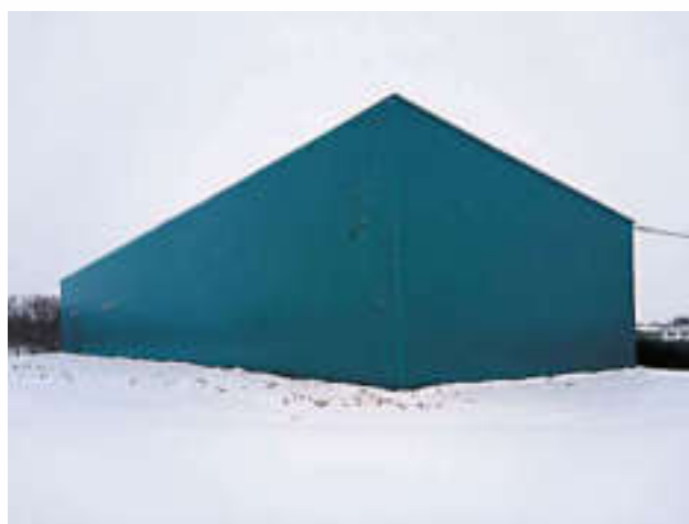
Богородицкий район, Тульская область. Каркасный утеплённый склад.
