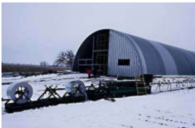
Торцевые стены закрываются прямыми профилями, которые, также как и арки, вальцуются друг с другом.
