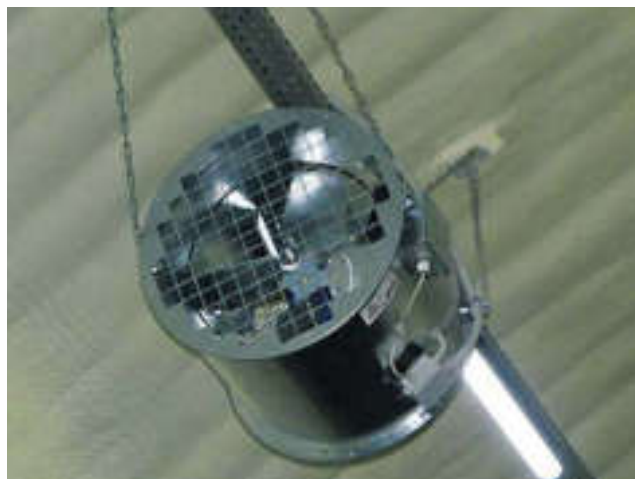
Противоконденсатный (разгонный) вентилятор с установленным электронагревателем воздуха.
