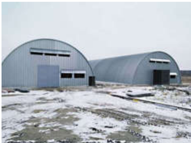
Картофелехранилища навального типа с активной вентиляцией. Шацкий район, Рязанская область.
