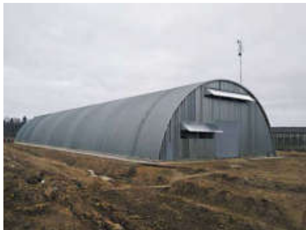
Двухканальное картофелехранилище навального типа с активной вентиляцией Старицкий район, Тверская область.
