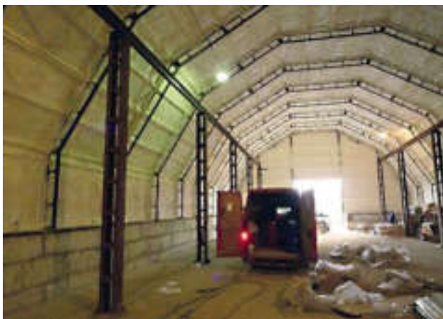
Утепление каркасного ангара.
