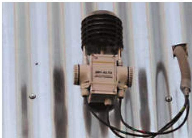
Датчики уличной температуры защищены противосолнечными экранами.
