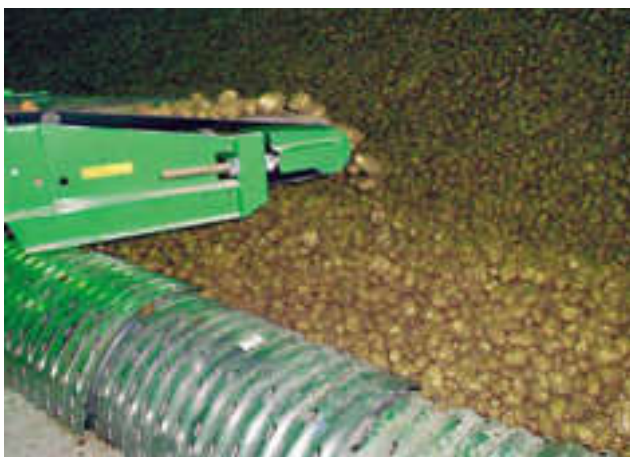
Собранные напольные вентканалы, сверху засыпаются продуктом.
