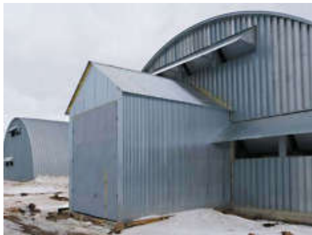
Картофелехранилище, оборудованное предбанником. Старицкий район, Тверская область.
