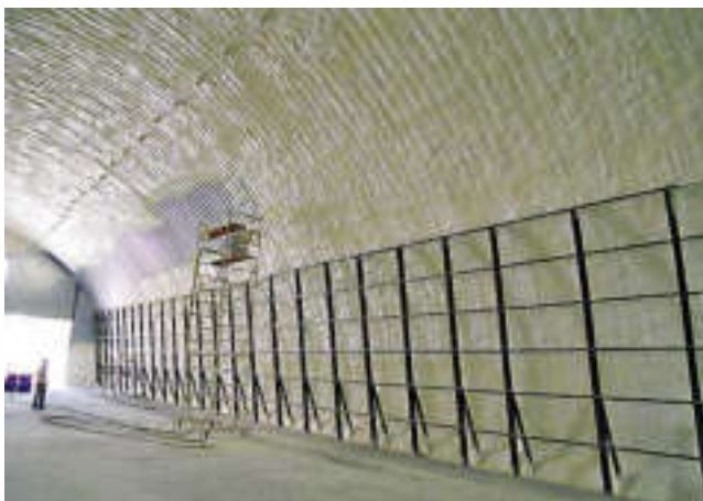
Утепление картофелехранилища на базе бескаркасного арочного ангара.
