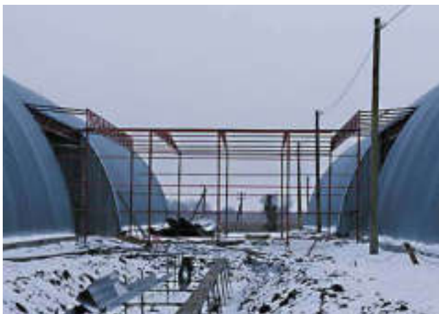
Монтаж перехода между бескаркасными ангарами.
