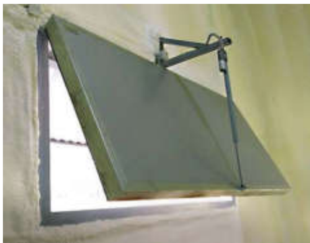
Автоматический утеплённый клапан – «VENTOGLAS™» оснащён подогревом уплотнителя. Управляется актуатором на 24В.
