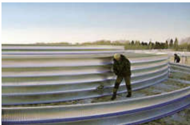
Соединение арок завальцовочной машинкой в секции по 5 штук.
