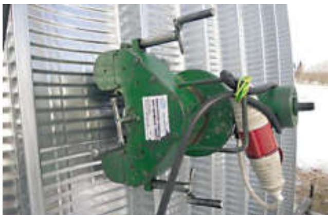
Закаточная машинка вальцует и самоходом продвигается вдоль арки.
