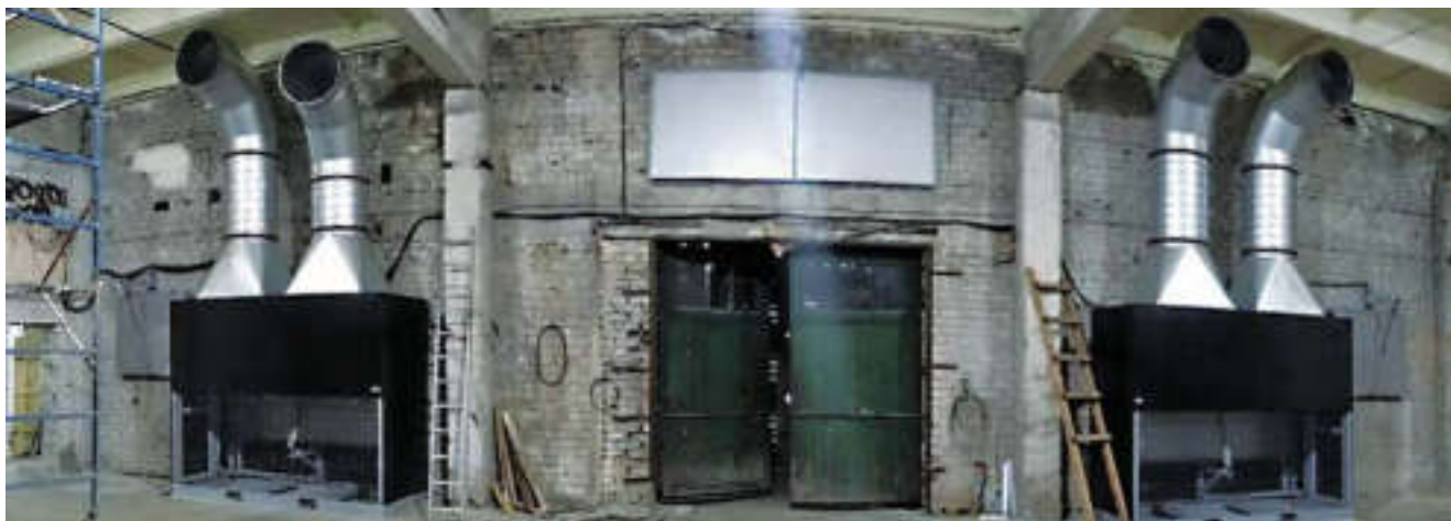
Реконструкция склада под овощехранилище контейнерного типа. Ульяновская область, город Вешкайма.
