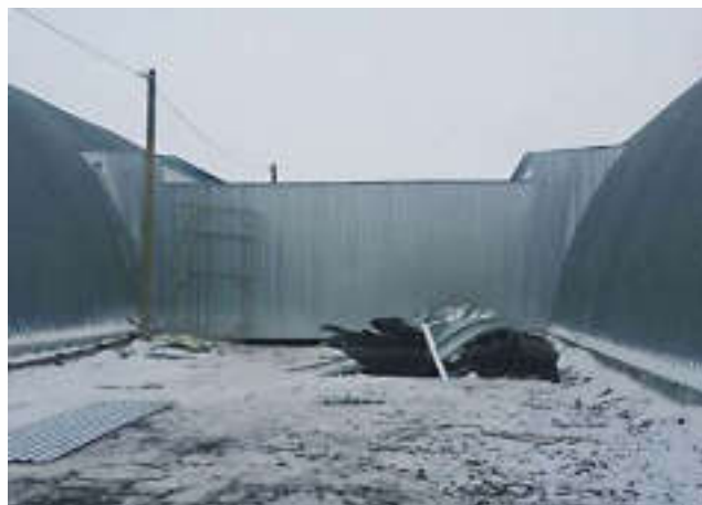
Переход обшит профилированным листом из оцинкованной стали.
