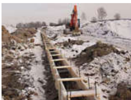
Изготовление опалубки.
