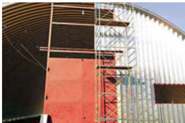
Проёмы ангара изготавливаются из металлоконструкций непосредственно на строительной площадке.
