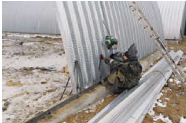
Секции арок крепятся к уголку, который приварен к закладным элементам фундамента.
