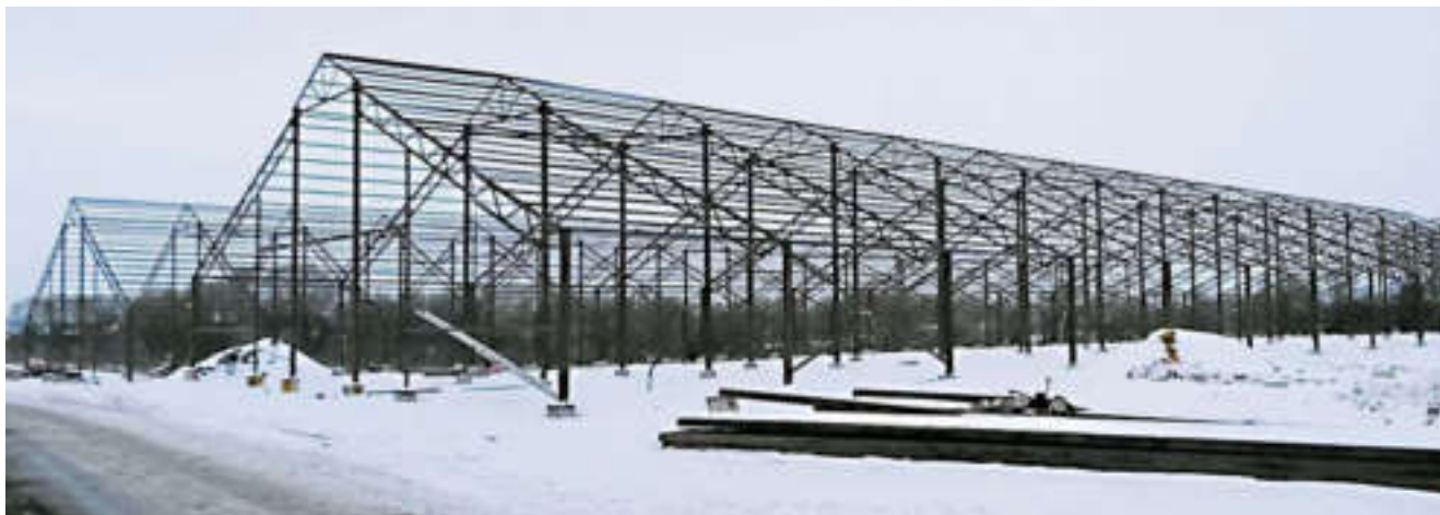
Металло-каркас. Строительство коровников. Тульская область.
