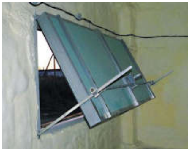
Автоматический утеплённый клапан – «VENTOGLAS™» управляется редуктором на 220В и оснащён подогревом уплотнителя.
