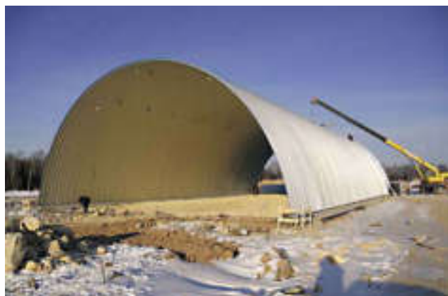
При установке «банки» ангара, важны погодные условия.
