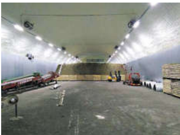
Картофелехранилище навалного типа с двухканальной системой активной вентиляции. Скопинский район, Рязанская область.
