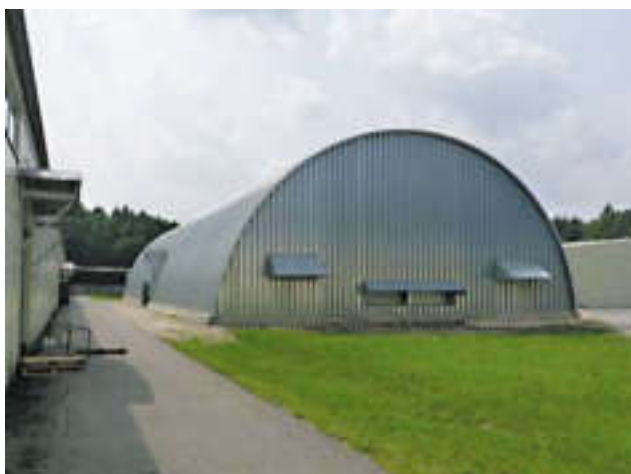
Контейнерное овощехранилище с двумя отдельными камерами. Орехово-Зуево, Московская область.
