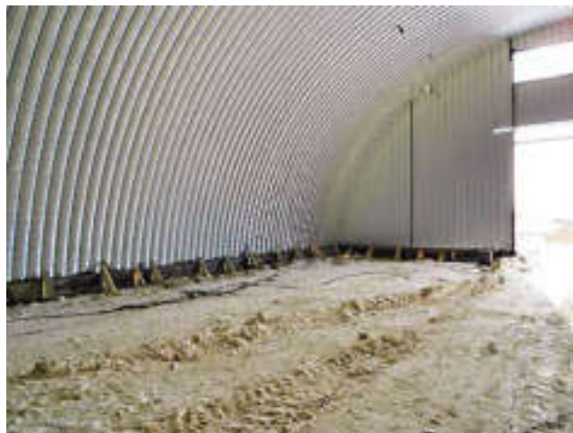
Монтаж опалубки для доливки фундамента внутри ангара.
