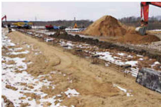
Установка закладных элементов и арматуры будущего фундамента.
