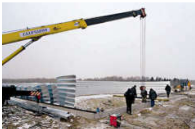
Соединённые в секции арки, готовы к установке на фундамент.
