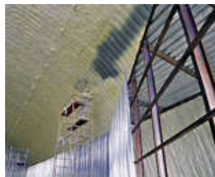
Утепление овощехранилища пенополиуретаном.
