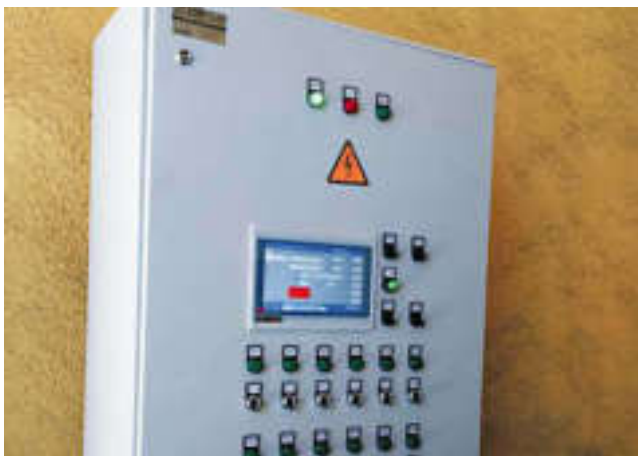
Блок управления на 12 напорных и 3 группы противоконденсатных вентиляторов.
