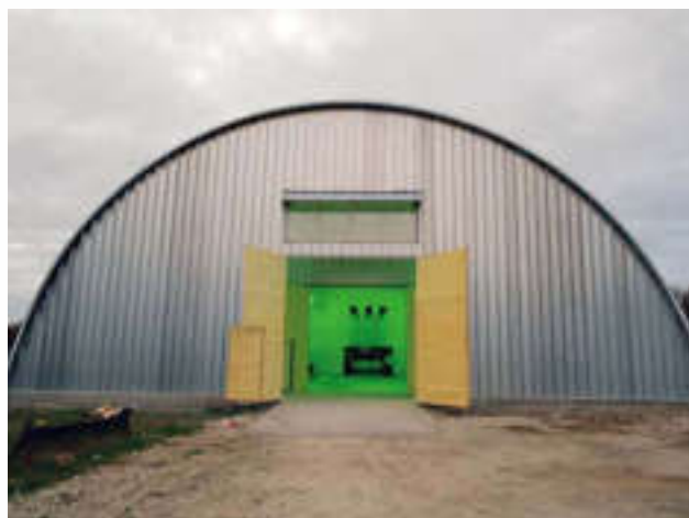
Хранилище контейнерного типа с пространственной вентиляцией. Суздальский район, Владимирская область.
