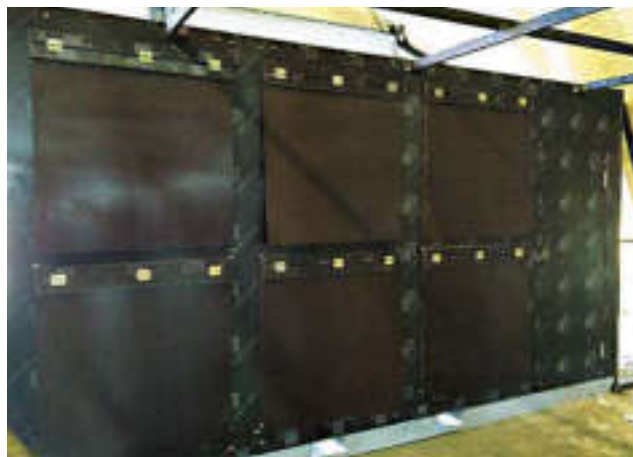
Обратные клапаны на вертикально установленных вентиляторах.
