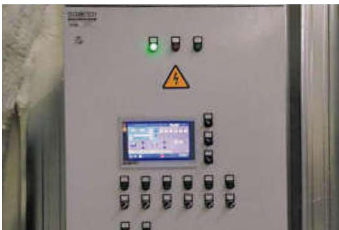
Блок управления VENTOGLAS™ со встроенным сенсорным программируемым контроллером (СПК) – являющимся электронной панелью управления.
