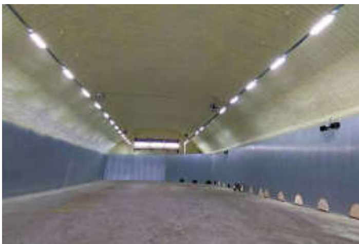
Хранилище для навалного (буртового) хранения. Для активной вентиляции продукта используются сборные напольные вентканалы VENTOGLAS™.
