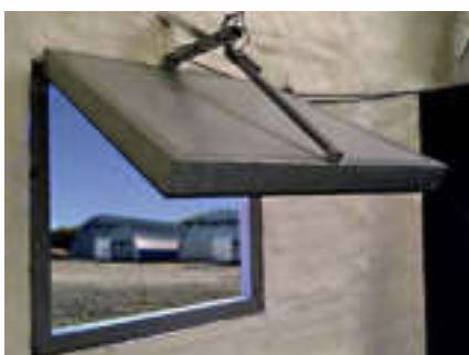
Клапан с электроприводом на 24 вольта.
