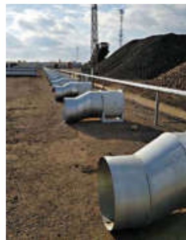
Установка вентиляторов с переходниками.
