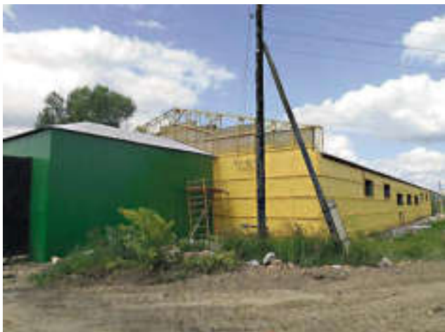
Полная реконструкция хранилища навального типа с утеплением, внешней отделкой и вентиляцией. Спасский район, Рязанская область.
