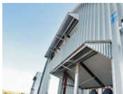
От осадков клапаны оборудованы козырьками.
