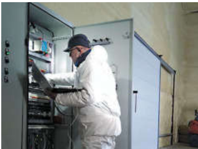
Специалист компании проводит настройку и компьютерную диагностику вентиляционной системы «VENTNOGLAS™».
