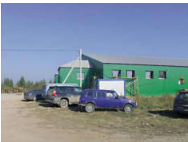
Полная реконструкция хранилища контейнерного типа (вентиляция - стена прямого действия). Спасский район, Рязанская область.
