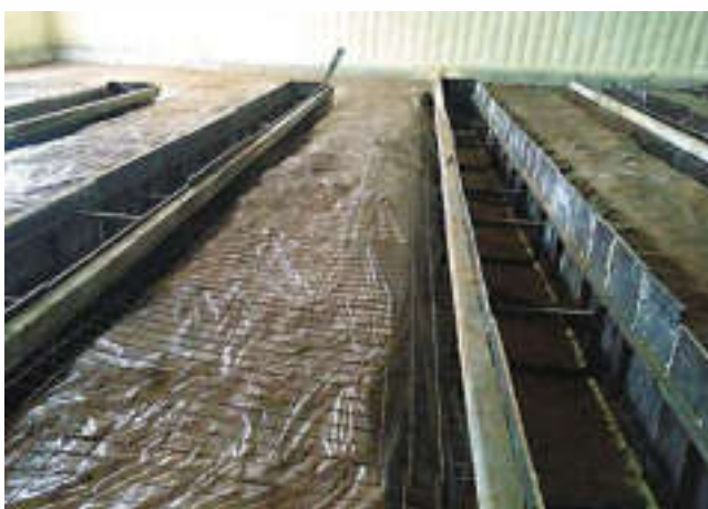
Подпольные вентиляционные каналы изготавливаются на месте.
