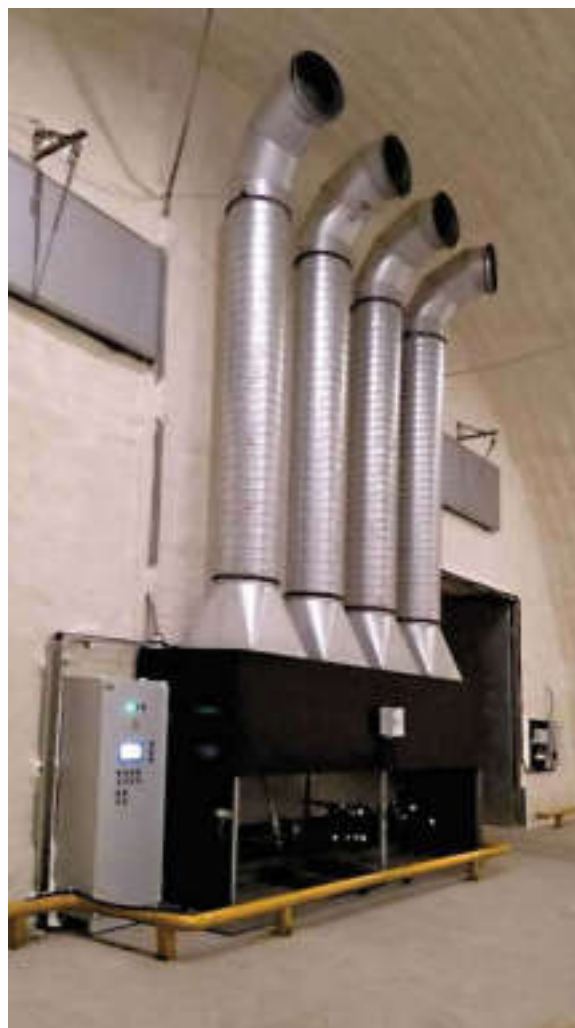
Модульная вентиляционная камера в хранилище контейнерного типа. На фронтальной стороне модуля, блок датчиков продукта.
