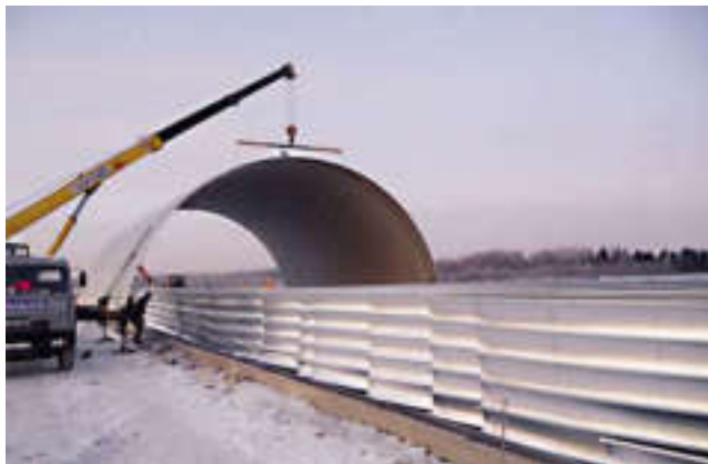
Заготовленные секции поднимаются краном.
