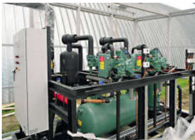
Монтаж агрегата холодильной машины для картофелехранилища.
