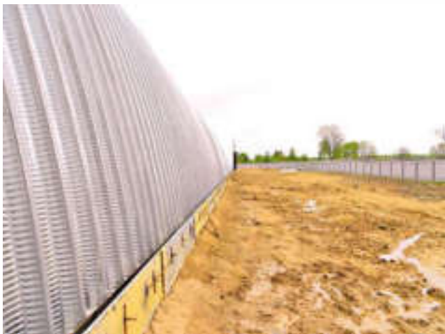
Смонтированная опалубка для наружной доливки фундамента.
