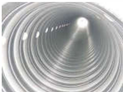
Вид кагатной трубы изнутри.
