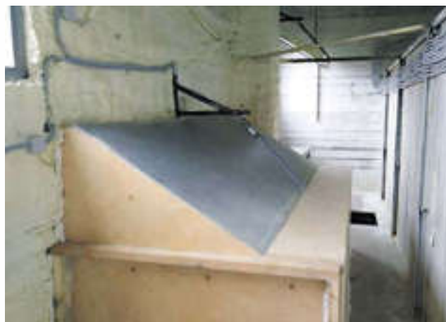
Полностью открытый приточный клапан, благодаря камере смешивания, обеспечивает подачу в канал только уличного воздуха.
