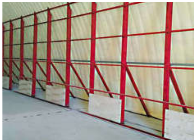
Перед обшивкой стен, к готовому каркасу сначала крепятся полукруглые крышки, которые перекрывают поток воздуха в напольные каналы.
